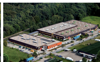
Planta de mecanizado NORD Gadebusch
