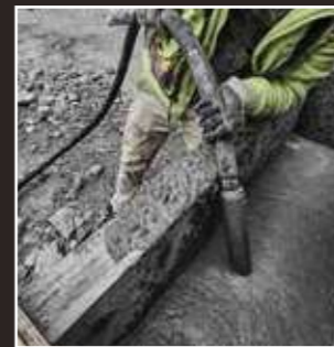
VIBRADOR DE HORMIGÓN
